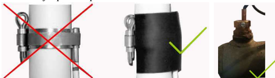
Obr. č. 8 – zapojení teplotních čidel
